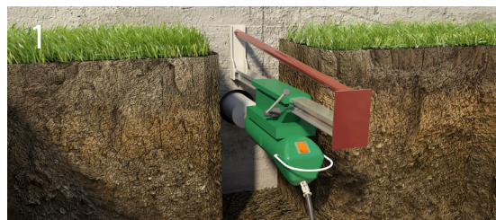
Алмазное сверление фундамента для прокладки канализационного трубопровода.
